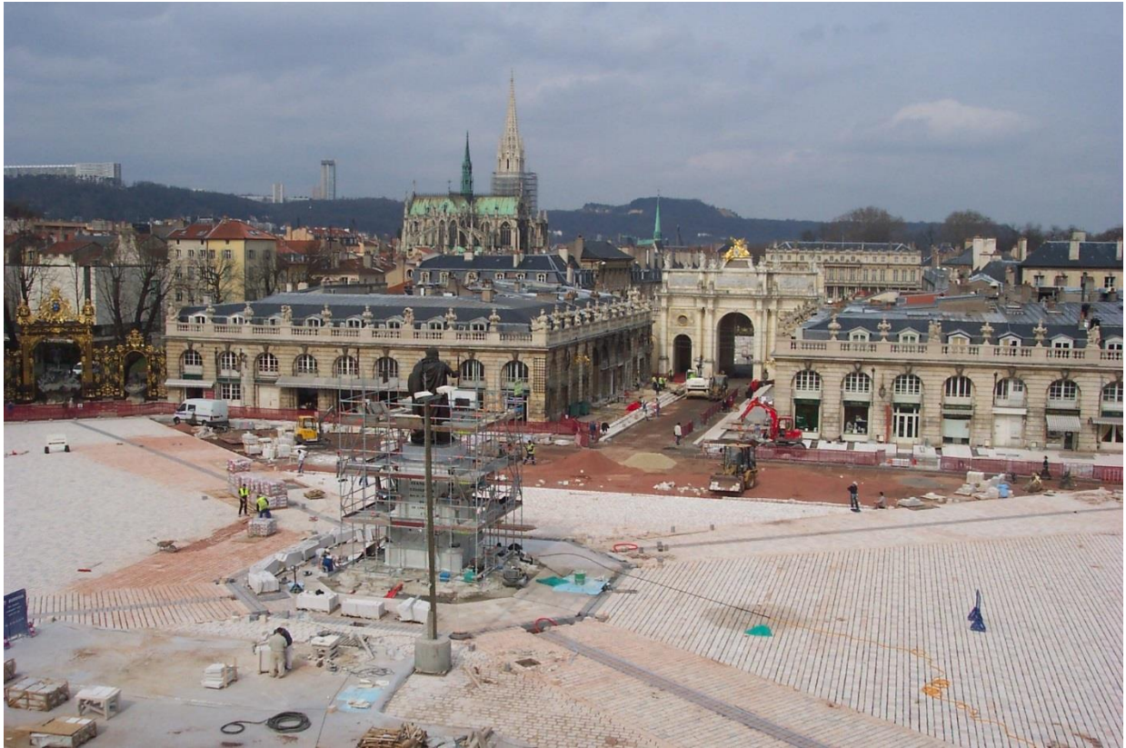
Chantier de restauration de la place Stanislas © Mairie de Nancy
